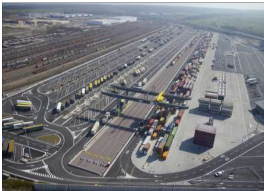
Der neue Terminal von Dudelange erlaubt seit Juli von 2017 den Vertikalumschlag (links) und Horizontalumschlag mit dem System Lohr (Bildmitte) für 700-Meter Züge erlauben; Foto: LOHR Industrie.
